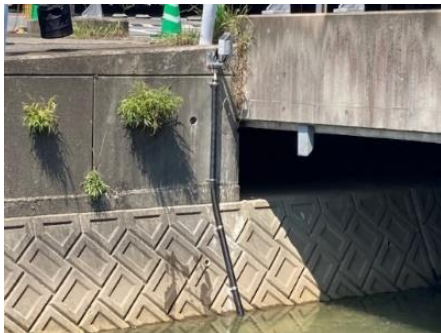
<設置した水位計>
